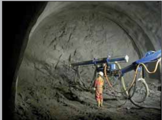
Hochgeschwindigkeit. Nass-Spritzverfahren beim Bauvorhaben Geißwandtunnel Traunkirchen.
