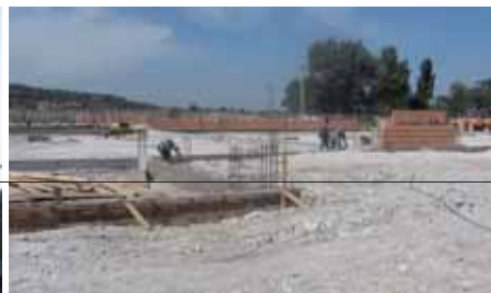
Baustart der Produktionsanlage. Der 1. Investor, „Mars“, startet mit dem Bau.
