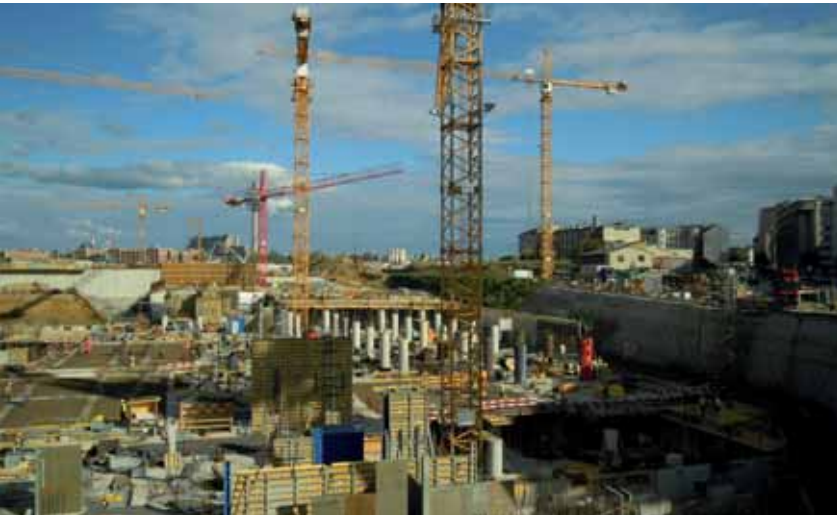
Bauarbeiten. Der neue Durchgangsbahnhof entsteht.
