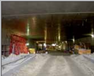
Brandbeständig. Einhausung Bindermichl.
