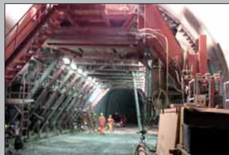
Innenschale. Geißwandtunnel Traunkirchen
