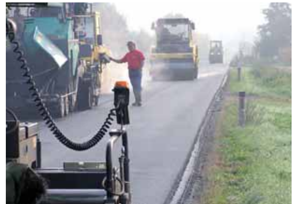
ASAPlex. Einbau von ASAPlex modifiziertem Asphalt.
